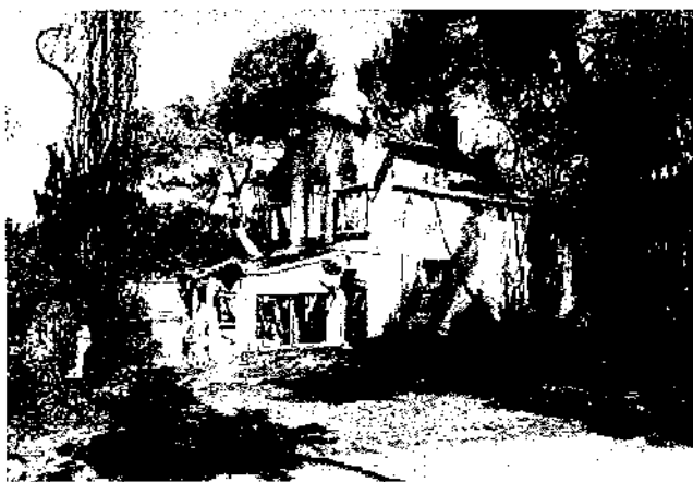
Maison non débroussaillée partiellement détruite par le passage d'un feu, Région Île-de-France - UNF
