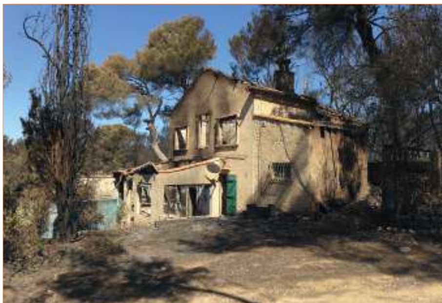
Maison non débroussaillée partiellement détruite par le passage d'un feu, Rognac (13) - source : ONF
